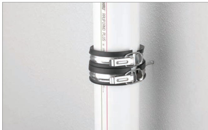
Рис. 8-3 Шумопоглощающий хомут в смонтированном состоянии
